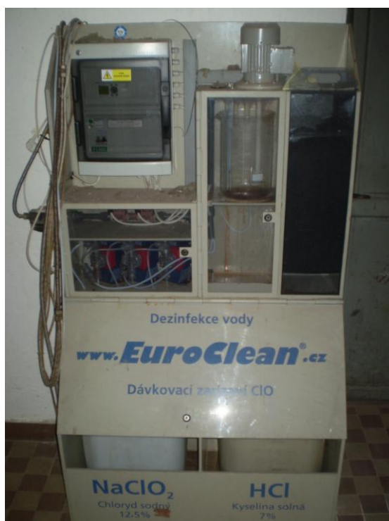
Příloha č. 3: Původní generátor chlordioxidu EuroClean (Zdroj: vlastní foto)
