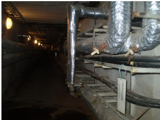
Příloha č. 5: Potrubní rozvody v podzemním kolektoru v Nemocnici Český Krumlov a.s. (Zdroj: vlastní foto)
