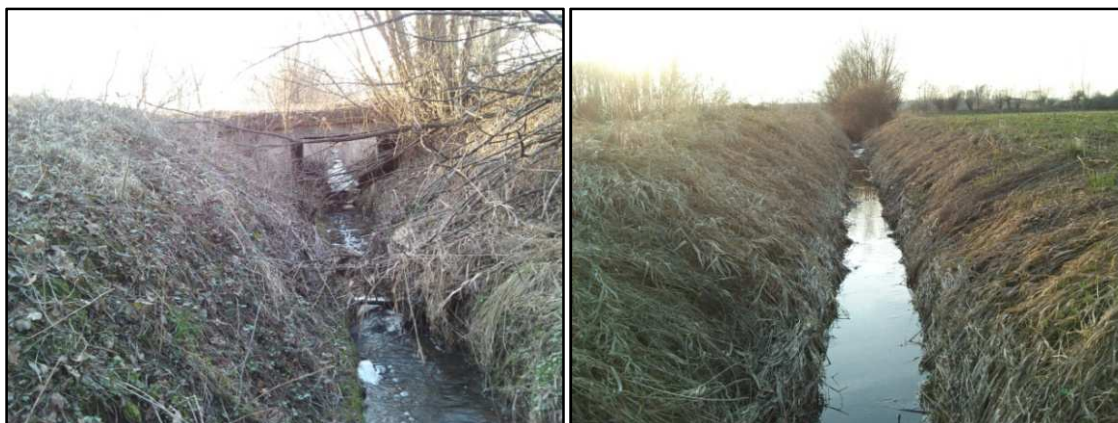
Obr. č. 15 Mostek přes úsek 1 (Jurenka, 2019)
