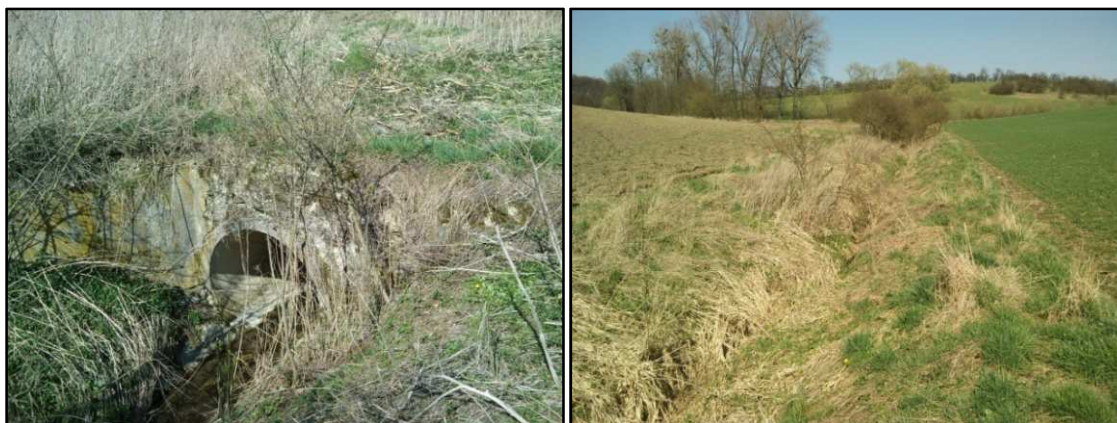
Obr. č. 25 Propustek, úsek 6 (Jurenka, 2019)
