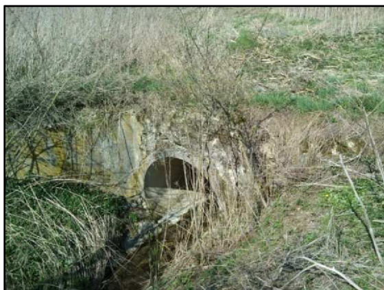
Obr. č. 25 Propustek, úsek 6 (Jurenka, 2019)
