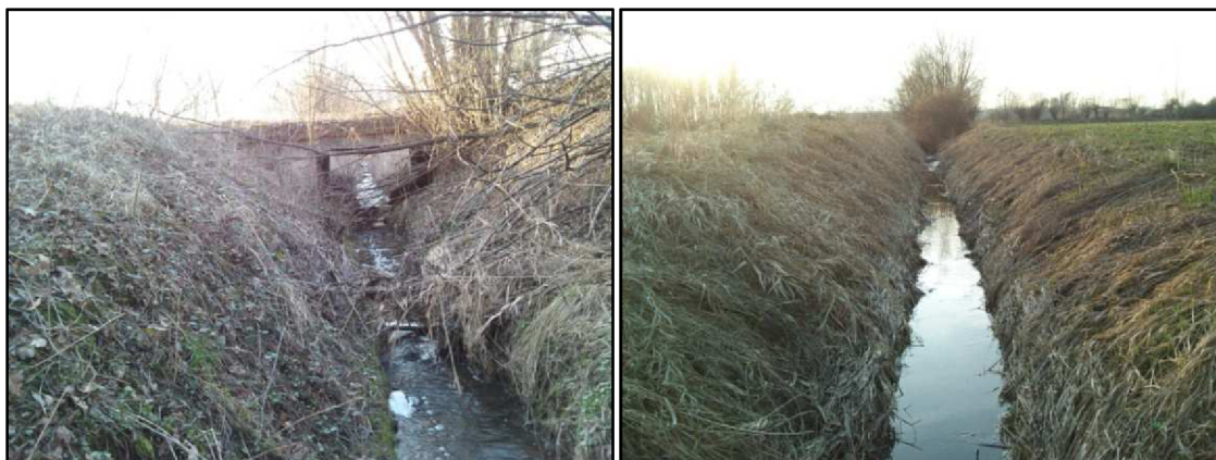
Obr. č. 15 Mostek přes úsek 1 (Jurenka, 2019)
