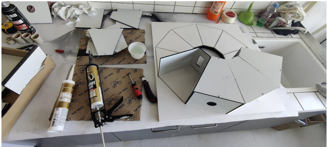
Obr. 28. Proces lepení komor
