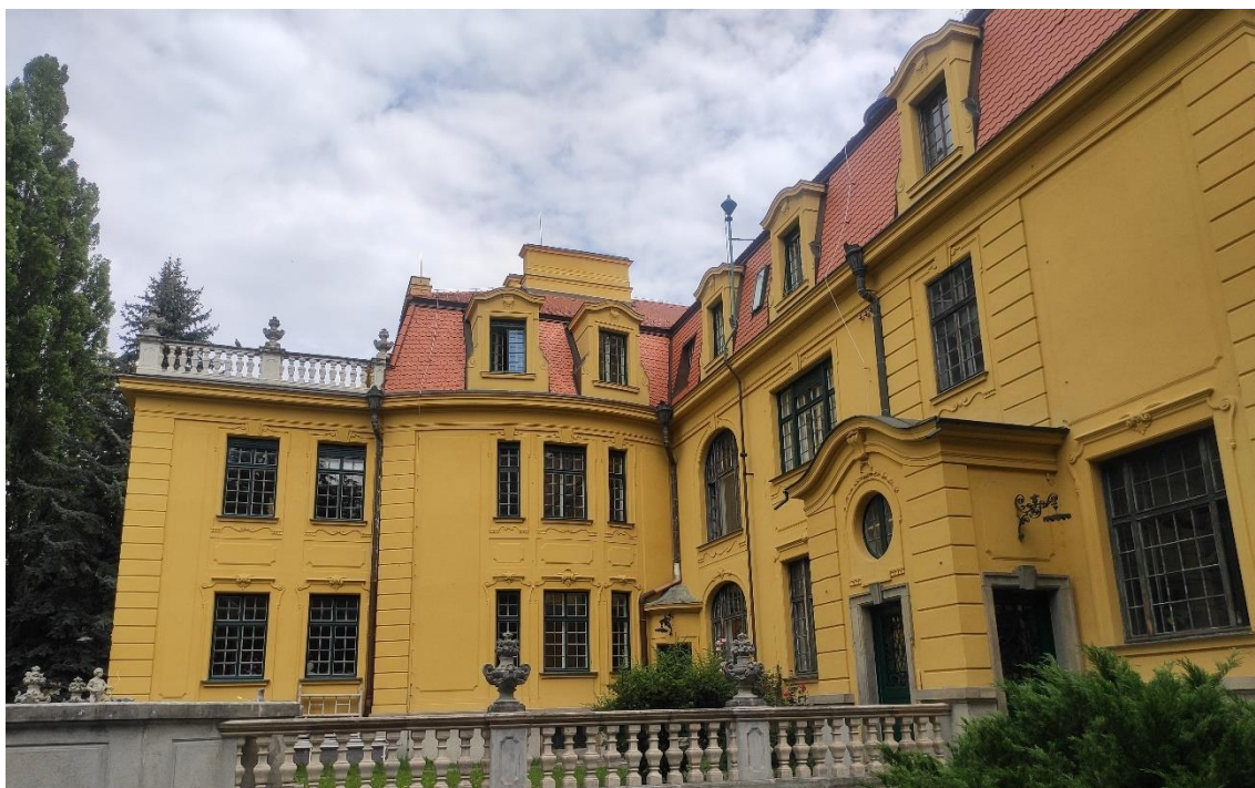
16 | Hardtmuthova vila, jihozápadní průčelí, foto: E. Skořepová
