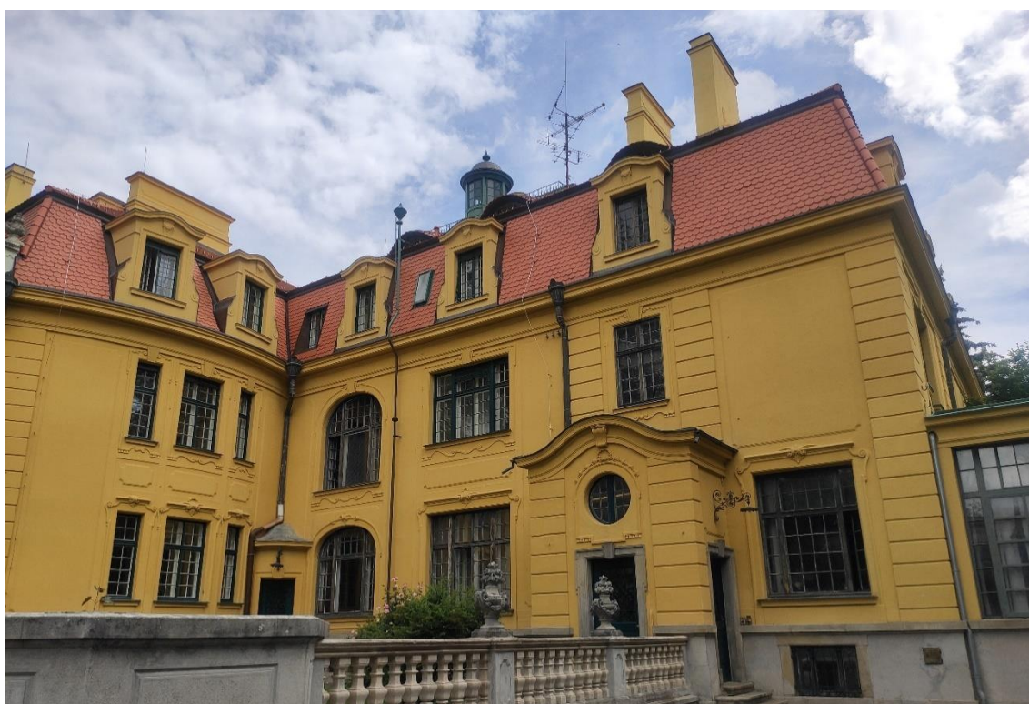
17 | Hardtmuthova vila, jihozápadní průčelí, foto: E. Skořepová
