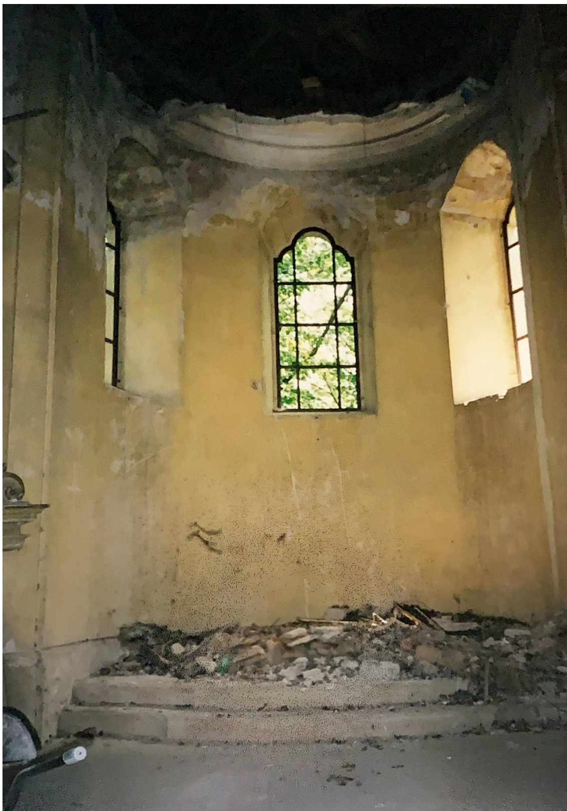
11 | Hrobka rodu Berchtoldů před restaurováním, interiér, foto: neuvedeno před r. 1999
