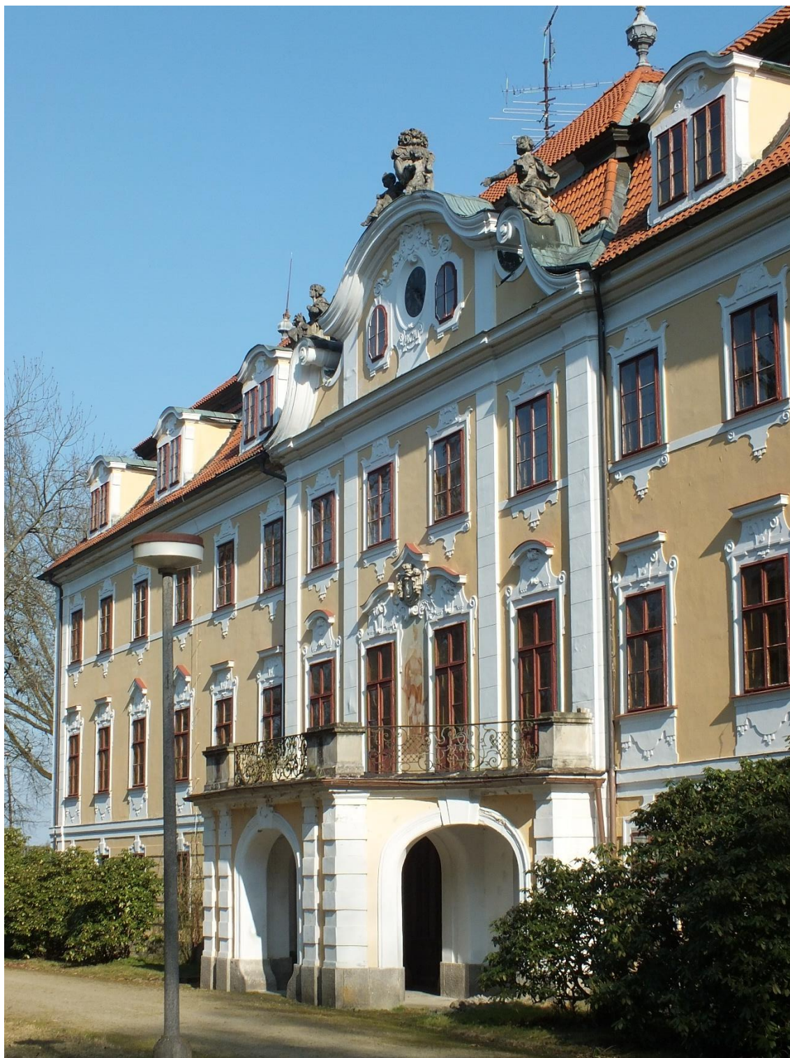
11 | Zámek v Chlumu u Třeboně, severozápadní průčelí, foto: E. Skořepová r. 2017 Zdroj: Archiv autorky DP
