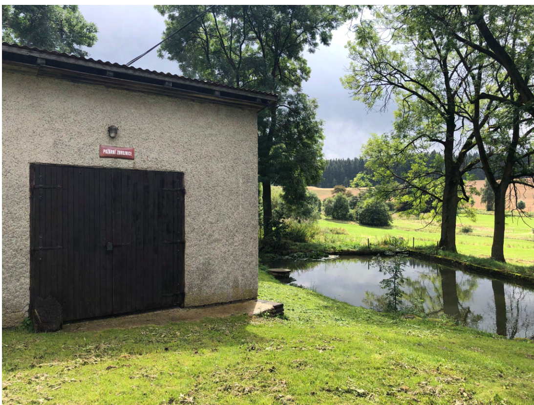
Fotografie 14 Požární nádrž v Hostišově (VP13) - obec Hostišov, srpen 2021
