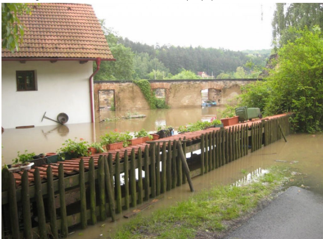
Fotografie č.18: Povodeň z roku 2013, Husinecký mlýn přibližně 60 metrů od toku
