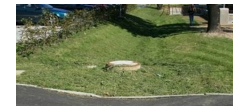
Obr. 39 - Ukázka průlehu u parkoviště, zdroj: 6
