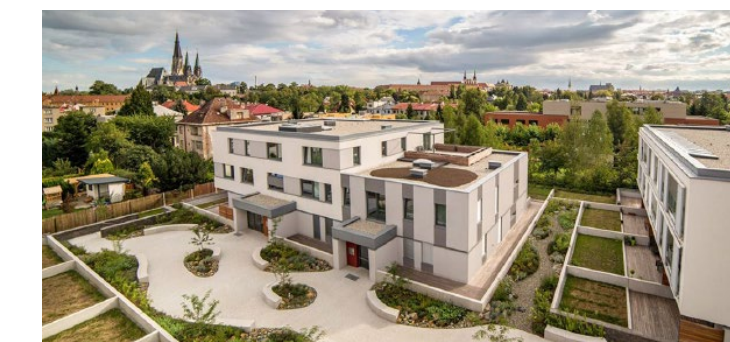
Obr. 22 - Olomouc (zahrada nad garážemi), zdroj: 3
