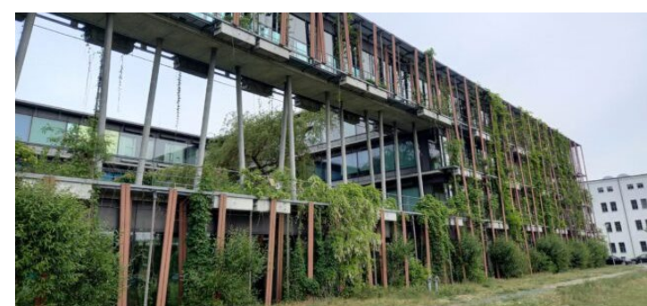
Obr. 9 - Vertikální zeleň na budově, zdroj: 1
