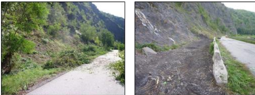
Obrázek 7.3 a 7.4 – Čištění skal a svahů - vyklizení akumulčního prostoru
