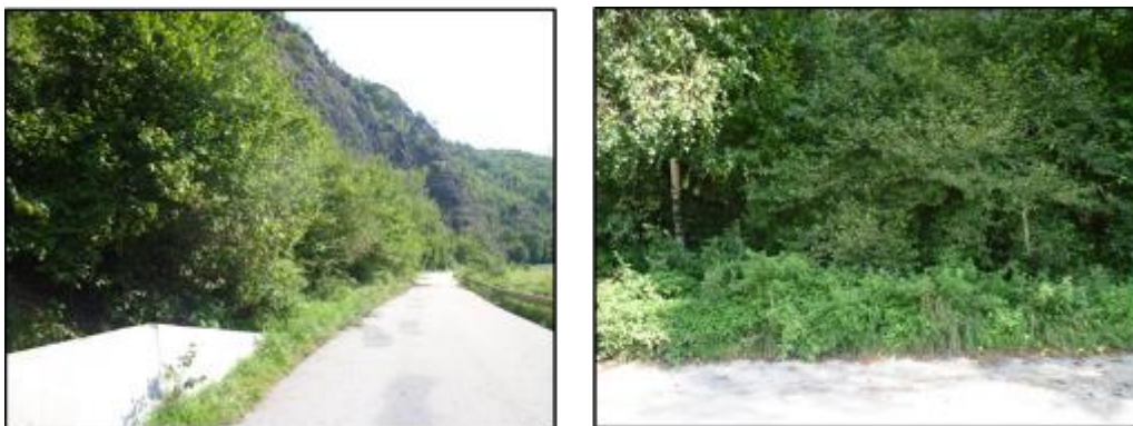
Obrázek 7.1 a 7.2 – Původní stav komunikace
