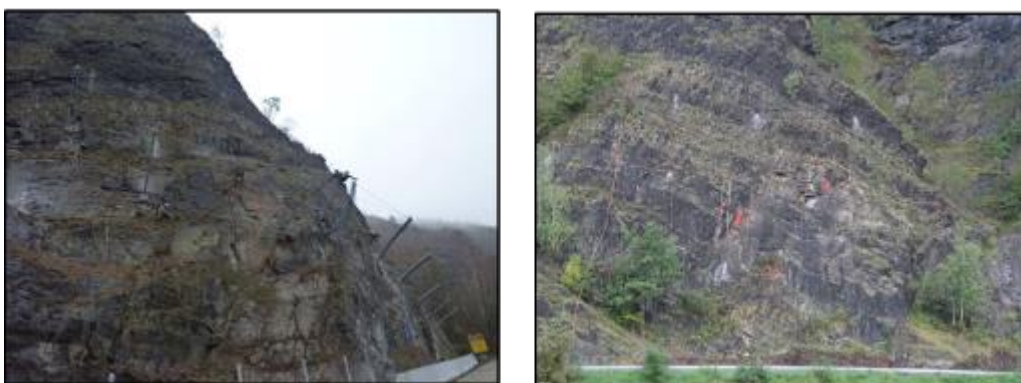
Obrázek 7.5 a 7.6 – Sanace skalní stěny ochrannou galerií SO 1
