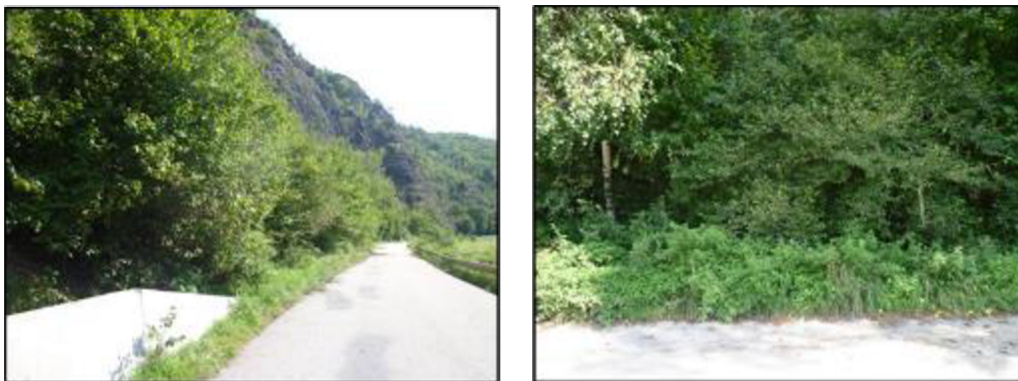
Obrázek 7.1 a 7.2 – Původní stav komunikace
