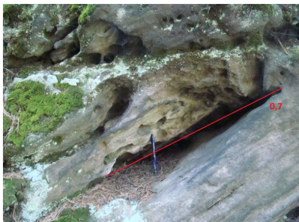
Obr. 53 Puklina ve stěně menšího srubu
