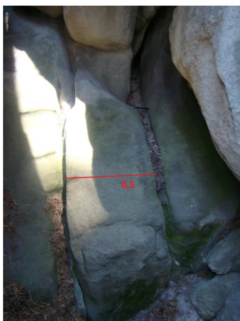
Obr. 36 Vnitřní část pukliny
