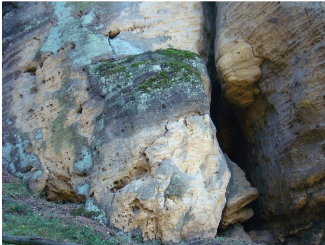
Obr. 104 Spodní část nejvýchodnějšího skalního srubu
