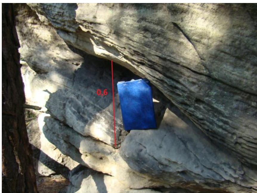
Obr. 49 Výrazná puklina v dolní části níže položeného skalního srubu
