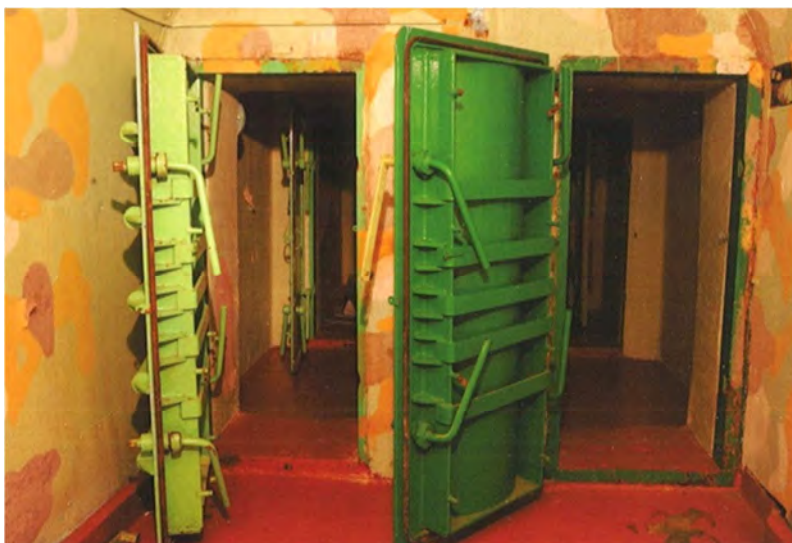
Obr. 19. Vstupní dveře do podzemního krytu jeskyně Výpustek (Zajíček 2010)
