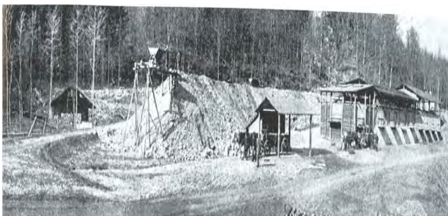
Obr. 14 Těžba fosfátové hlíny v jeskyni Výpustek. Hlína byla vyvážena po úzkokolejné dráze ven a následně tříděna dle obsahu fosfátu (Frodl 1923)
