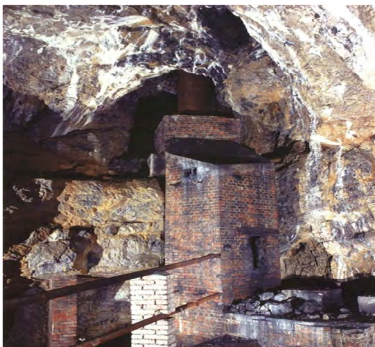
Obr. 18 Viditelně ohořelé zbytky továrny vybudované v jeskyni Výpustek německou armádou (Zajíček 2010)
