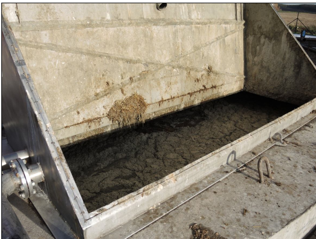
Příjmová jímka (foto autora, 2013)
