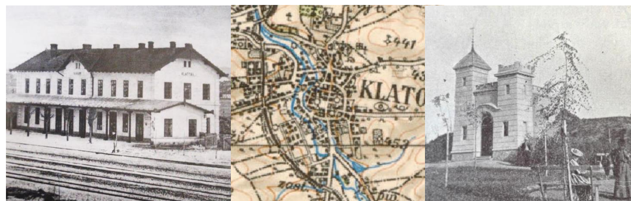
Obr. 13 Budova nově vzniklého nádraží, rok 1876
