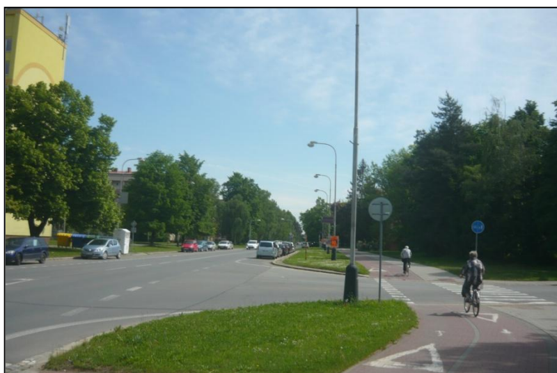
Obrázek č. 31: Ulice Dvořákova – pohled na cyklostezku a veřejnou zeleň
