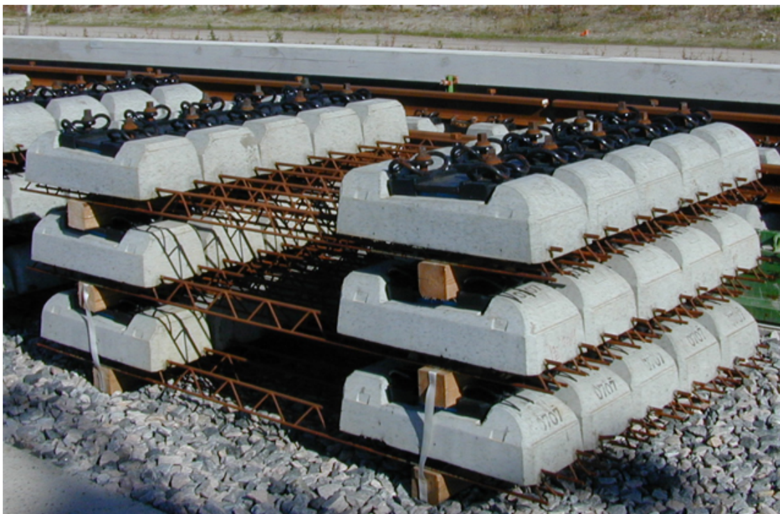
Obrázek 8: Dvoublokové pražce používané v systému RHEDA 2000 [14]
