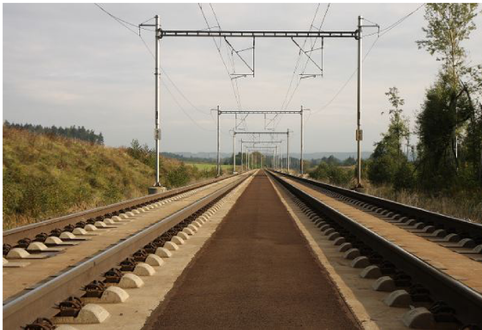
Obrázek 1: Pevná jízdni dráha typu RHEDA 2000 v úseku Třebovice-Rudoltice [8]
