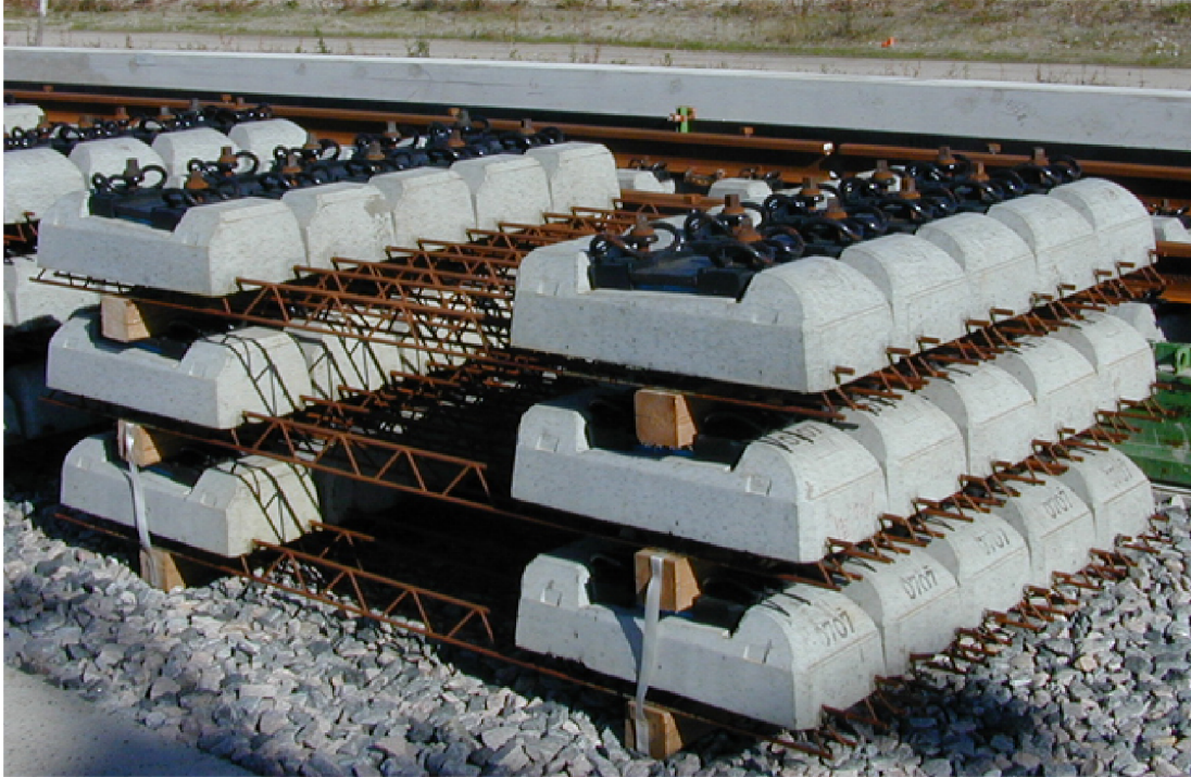
Obrázek 8: Dvoublokové práčky používané v systému RHEDA 2000 [14]
