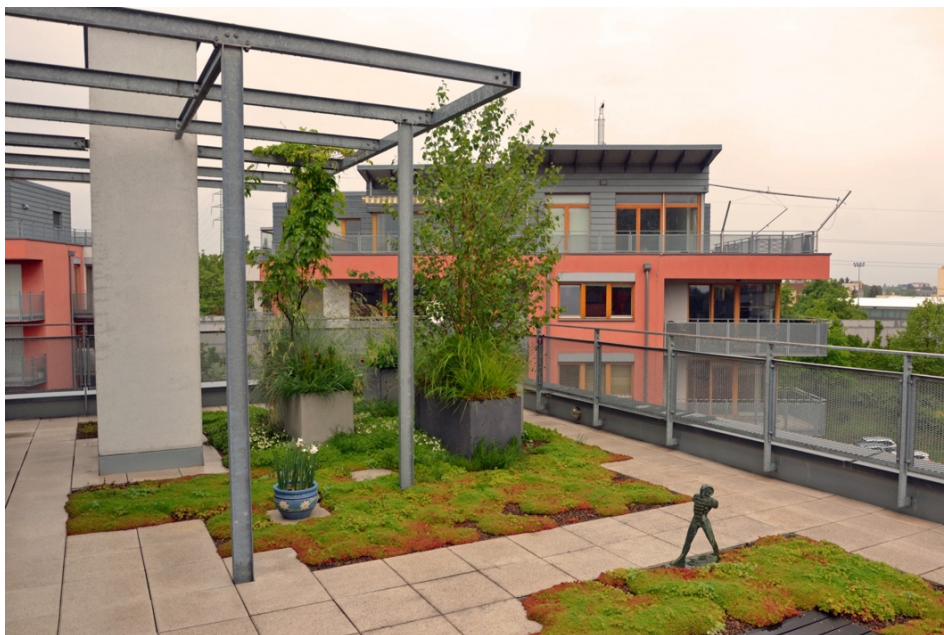
Obrázok 23 Polo intenzívna pobytová zelená strecha na terase bytového domu v Praze od ateliéru Partero.( https://www.zelenastrecharoku.cz/cs/ , 2019)
