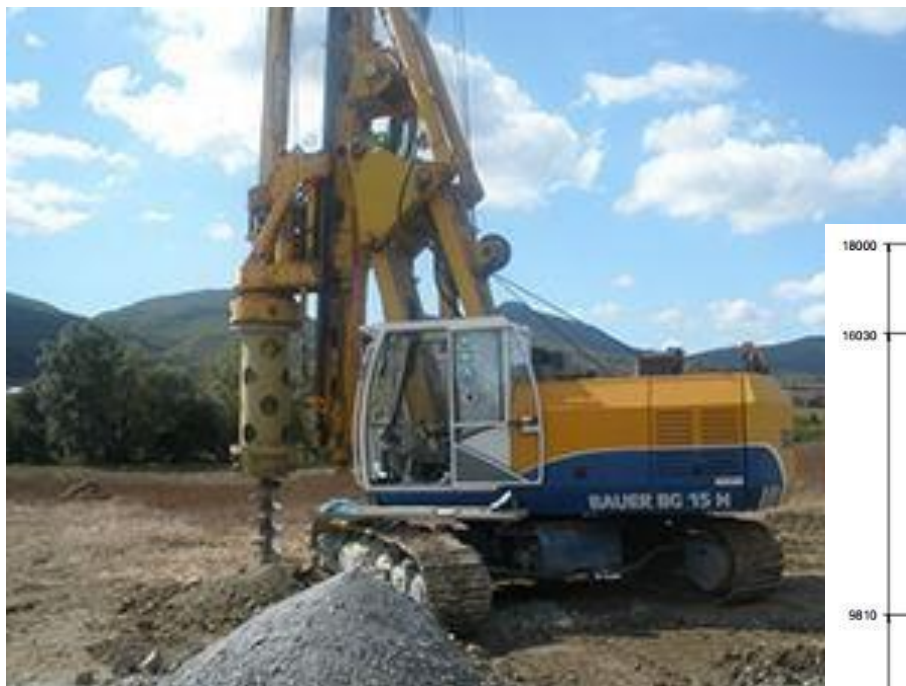
Obr. 23 – Vrtná souprava Bauer BG 15 H
