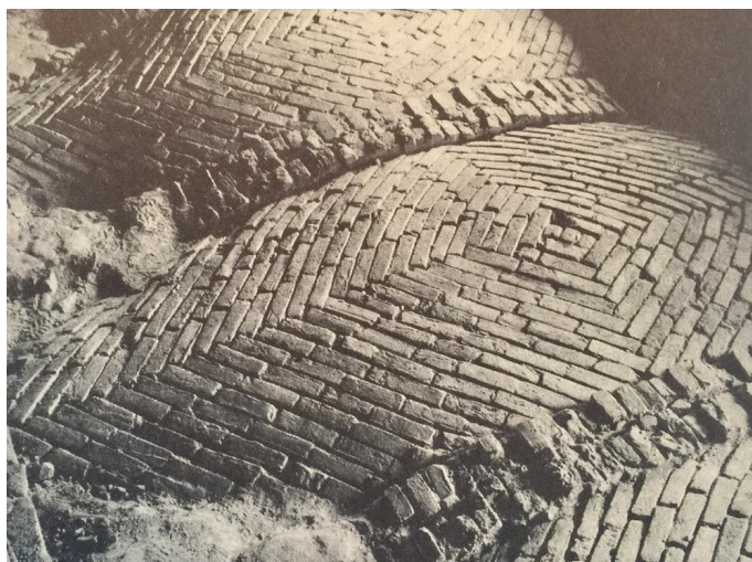
Obr. č. 6 Řada plackových kleneb s pasy, kosočtverečná skladba cihel (Škabrada, 1999).
