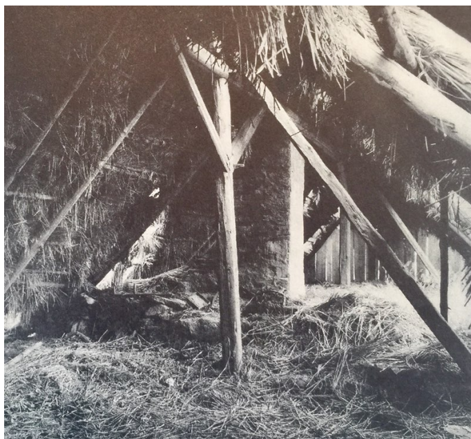
Obr. č. 8 Starobylý typ krovu s krokviemi zavěšenými přes hřebenovou vaznici (Škabrada, 1999).
