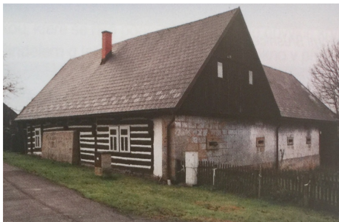
Obr. č. 22 Neratov – roubený dům s ostře ukončeným šindelovým štítem (Křivanová a Štěpán, 2001).
