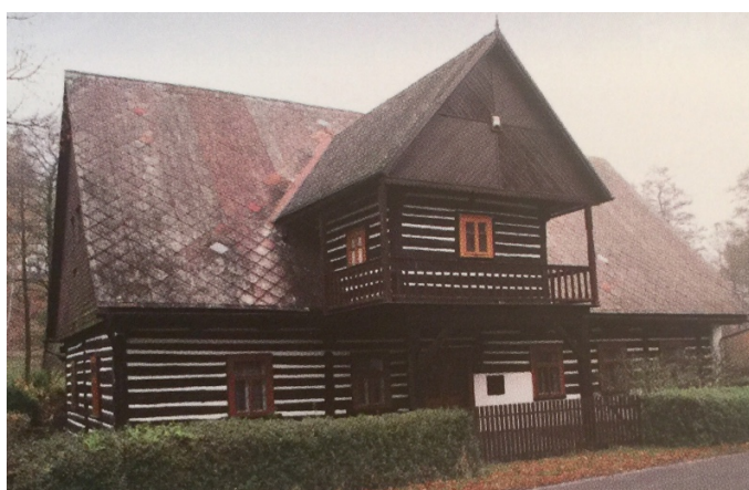
Obr. č. 20 Horní brusnice – předsazená roubená jizba s pavláčkou (Vondruška a Vondrušková, 2014).
