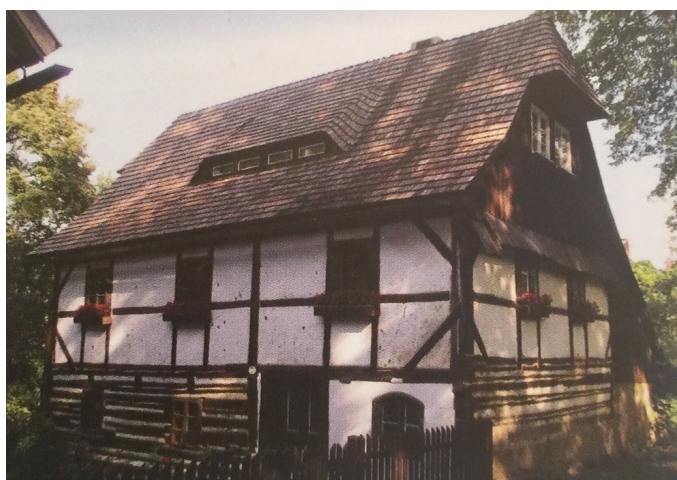
Obr. č. 20 Horní brusnice – předsazená roubená jizba s pavláčkou (Vondruška a Vondrušková, 2014).
