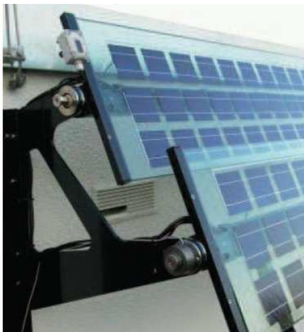
Obr. 4: Stínící prvky s fotovoltaickými články (zdroj [3])
