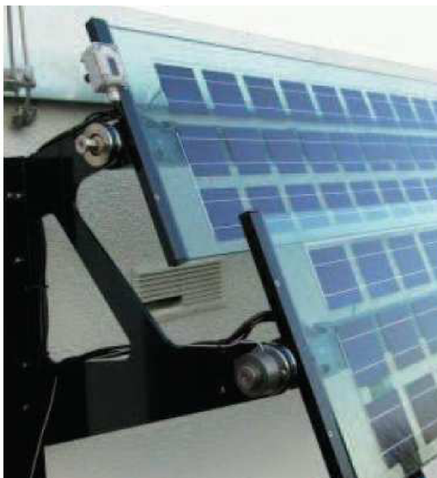
Obr. 4: Stínící prvky s fotovoltaickými články (zdroj [3])
