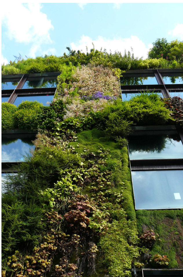
Obr. č. 22. Pohled na stěnu s rostlinami budovy MQB
