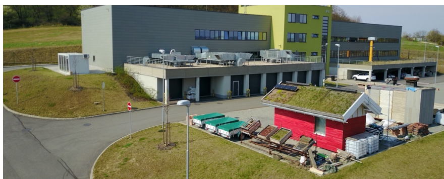
Obrázek č. 13: Areál ADMASu a objekt EnviHUT (zdroj: autor, 2017)
