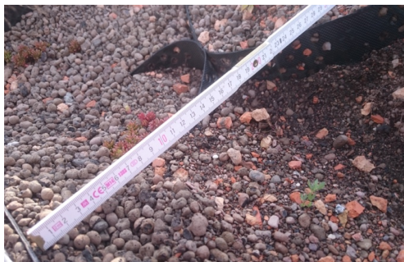
Obrázek č. 21: Sesuv u okapu na jižní straně (zdroj: autor, 2016)
