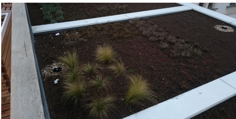
Obrázek č. 4: Zelená střecha na střeše Tržnice v Brně (zdroj: autor, 2017)
