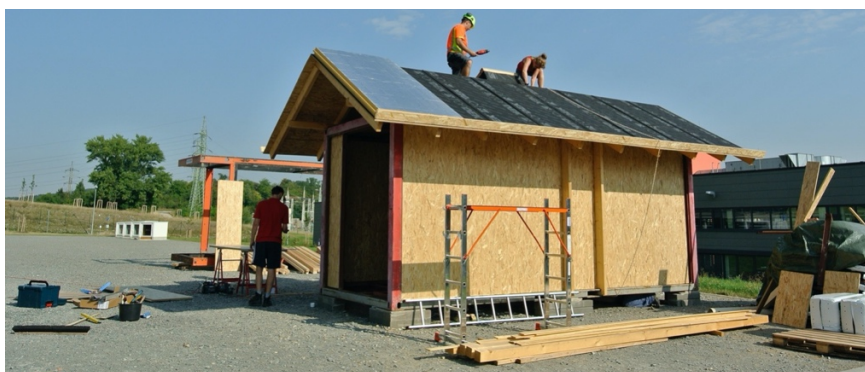
Obrázek č. 12: Začátek výstavby objektu EnviHUT (zdroj: autor, 2015)
