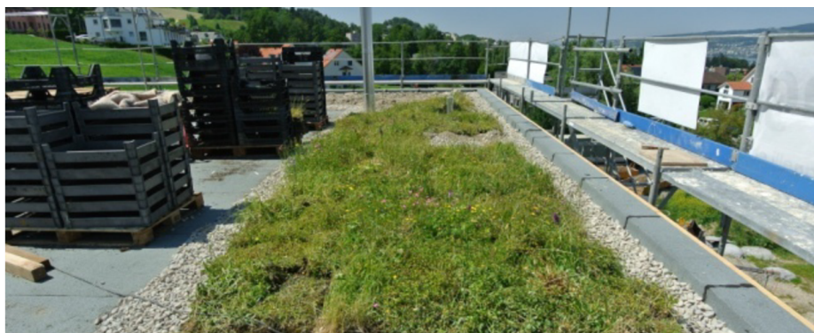
Obrázek č. 3: Nová instalace ploché vegetační střechy ve vesnici Wädenswil(zdroj: autor, 2015)
