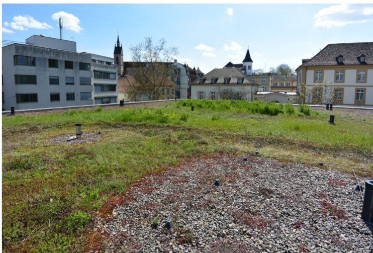
Obrázek č. 1: Biodiverzní střecha objektu Klinikum II v Basileji (zdroj: autor, 2015)
