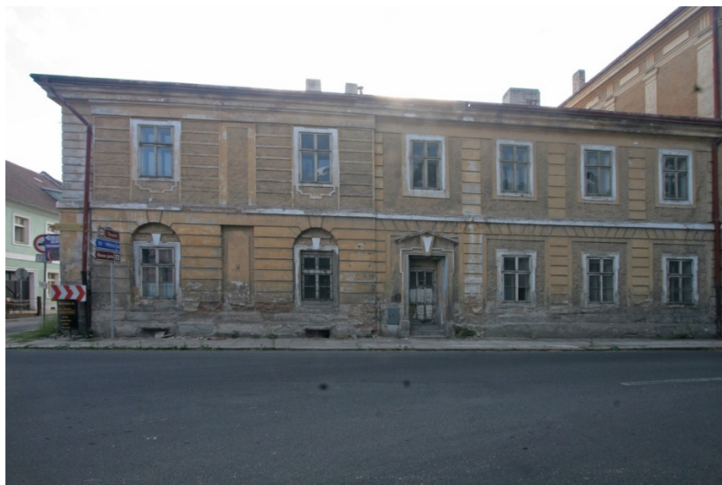
Obrázek 9 Wieserův dům před rekonstrukcí
