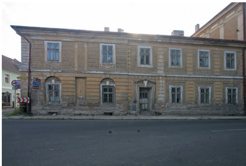
Obrázek 9 Wieserův dům před rekonstrukcí
