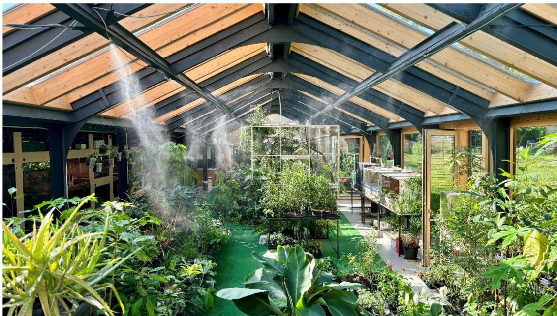
Obrázok 63 Nainštalované a zapnuté trysky
