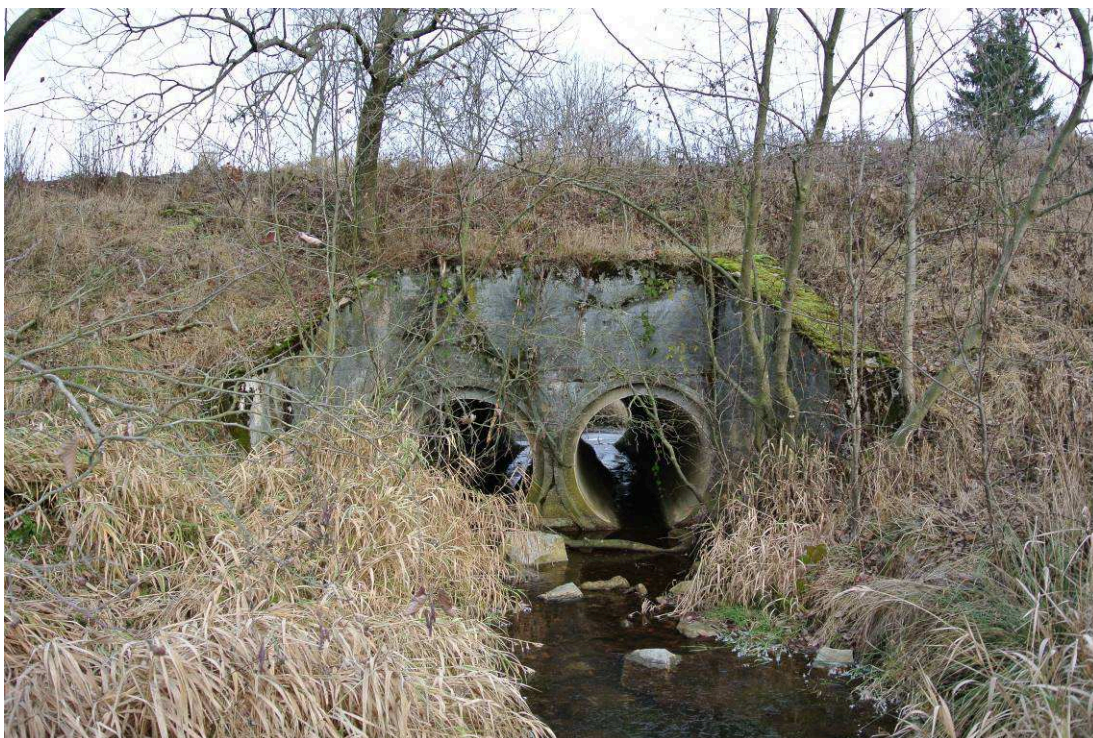
Obr. č. 16, Propust hrází. Foto: Databáze projektu TB030MZP114.
