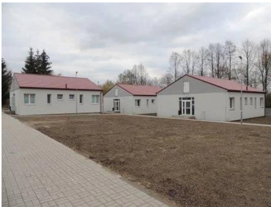
Obrázek 1. Foto výstavby Otevřené věznice v Jiřicích
