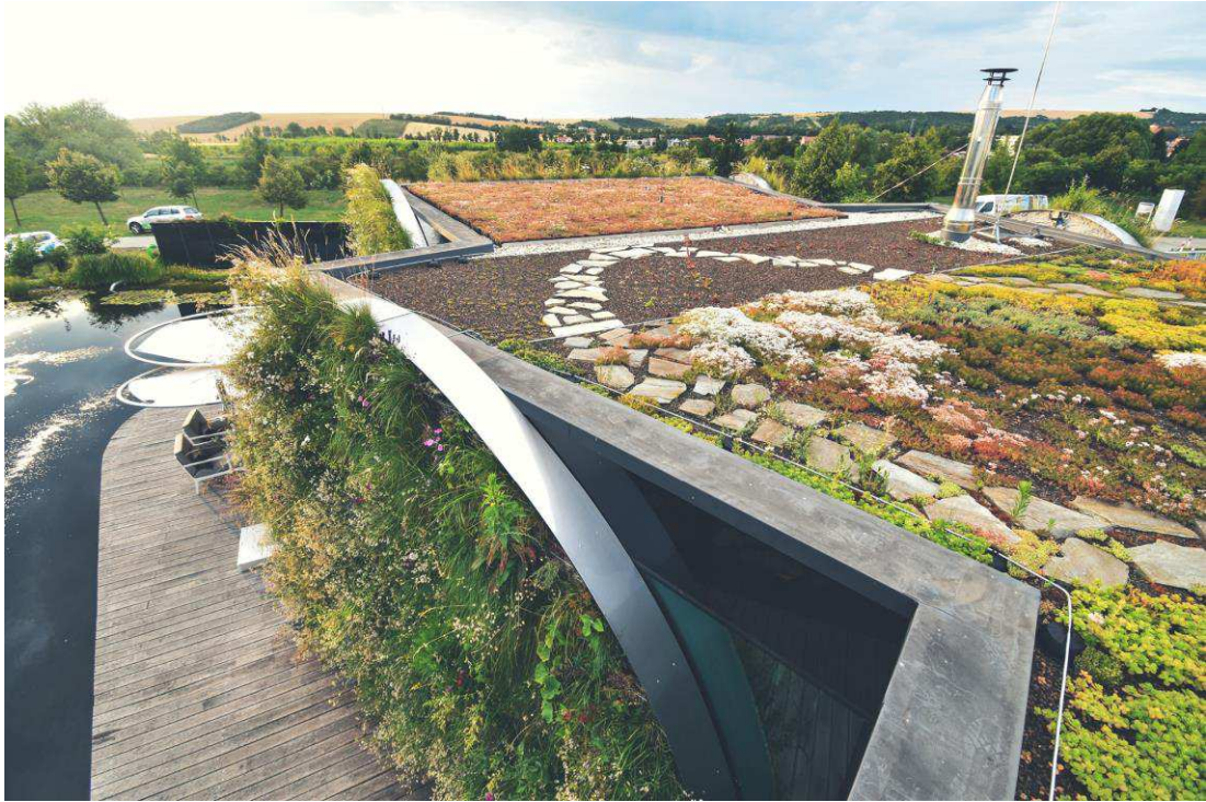
Obrázek 11 Zelená střecha objektu LIKO-Noe (zdroj: www.liko-noe.cz )
