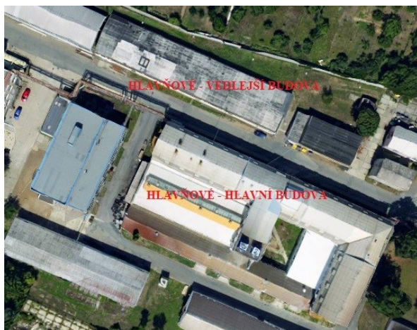
Obr. 2.3 Letecký pohled na budovy provozu Hlavňové
