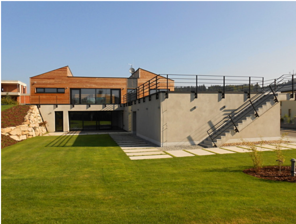
OBR. 24. Rodinný dům Horská: Pohled na dům, v popředí garáž se střešní terasou.
