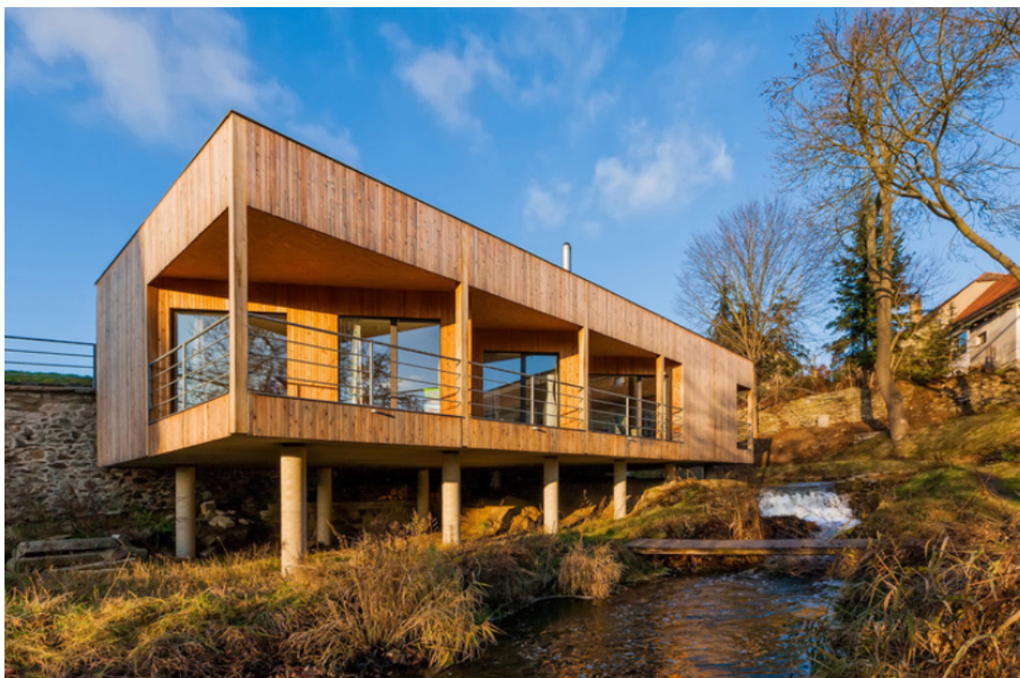
OBR. 18. Dům nad vodopádem: Pohled na využitelný prostor mezi betonovými sloupy.
