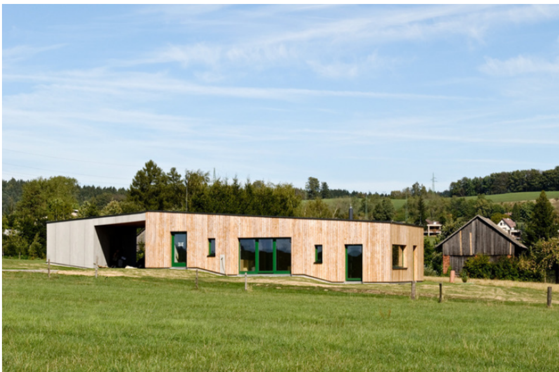
OBR. 22. Rodinný dům Vrabec: Pohled na rodinný dům přes louku.
