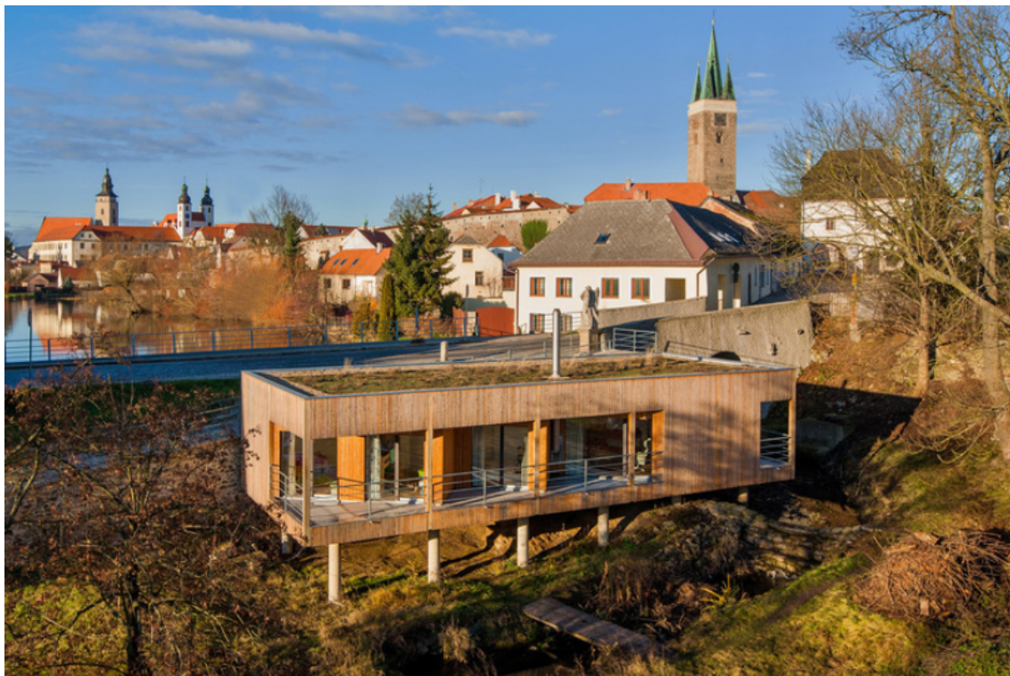
OBR. 17. Dům nad vodopádem: Pohled na zelenou střechu.
