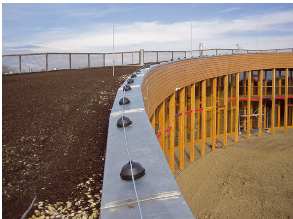
OBR. 16. Sluňákov: Okraj zelené střechy v průběhu realizace.
