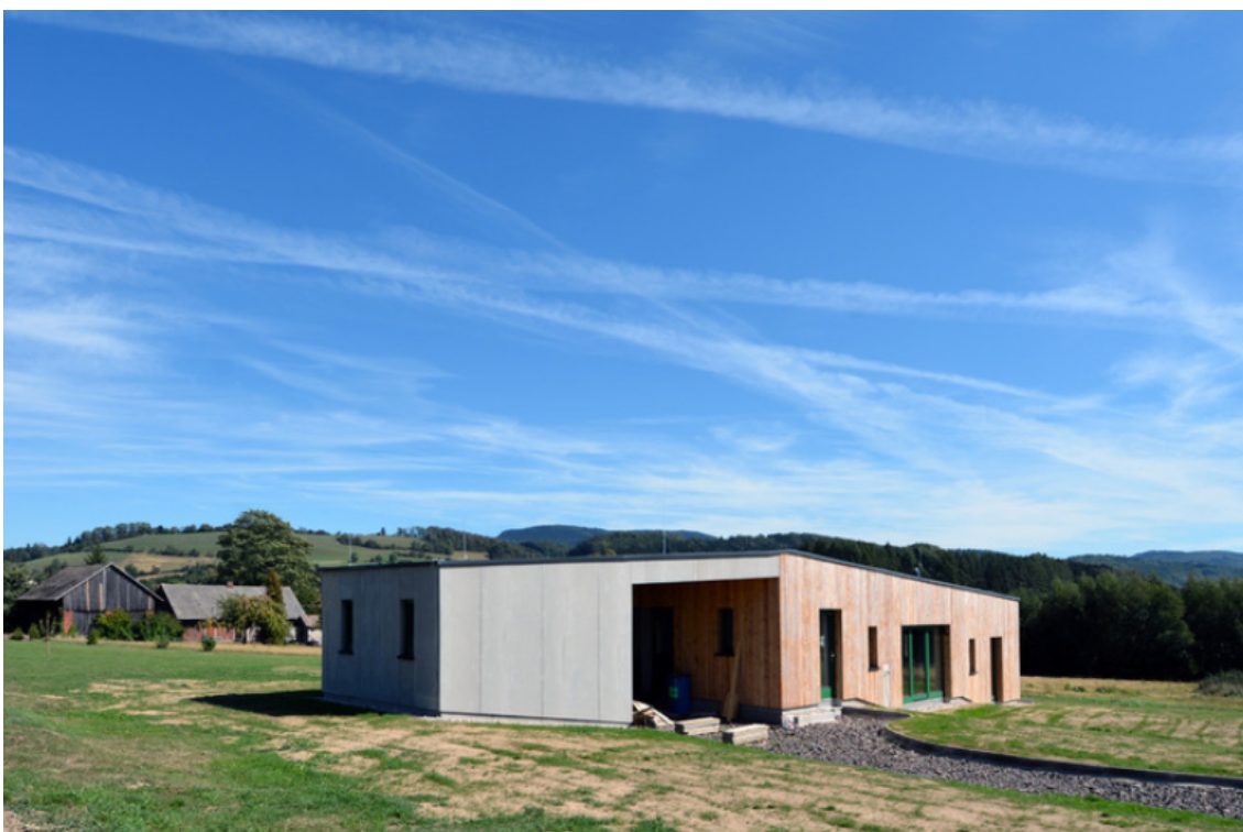
OBR. 23. Rodinný dům Vrabec: Přístup do rodinného domu
