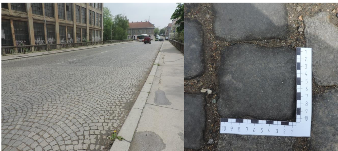
Obr. 45 Pohled na místo měření na třetím měřeném úseku a detail měřeného povrchu [4]
