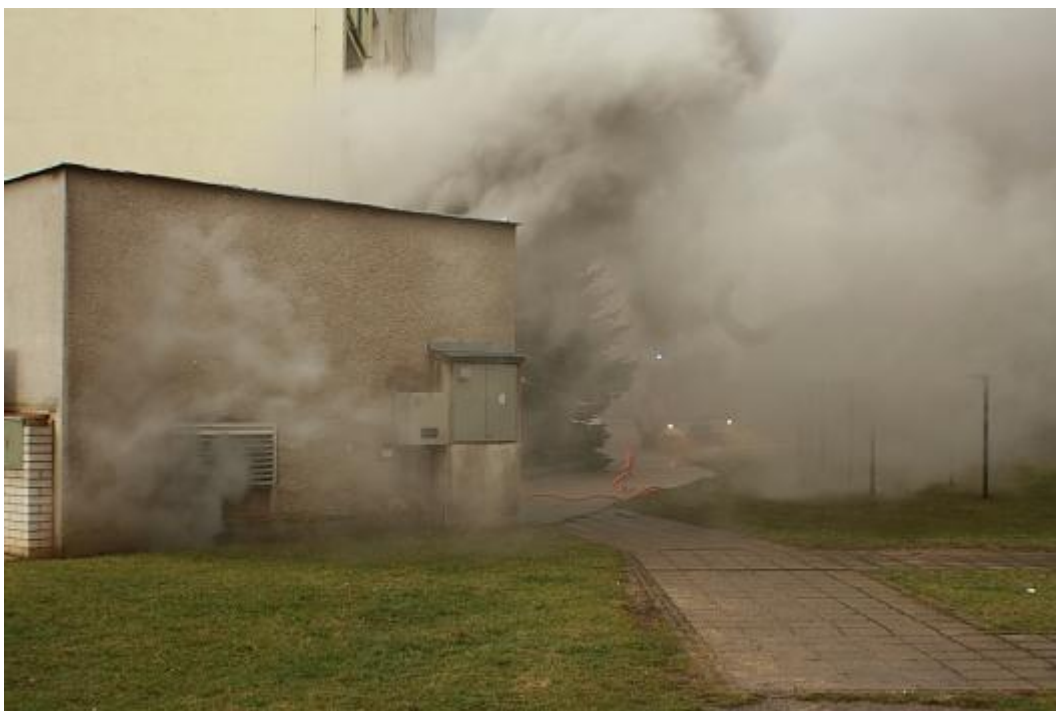
Obr. 24: Požár trafostanice 14. 1. 2011 v Roudnici nad Labem.
