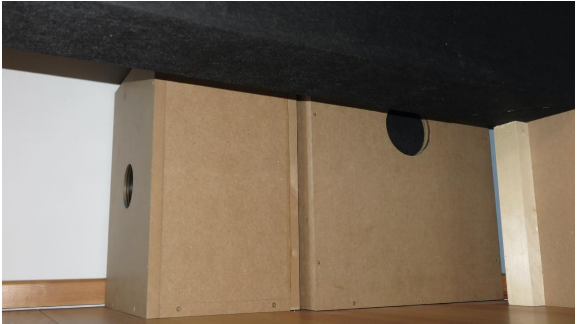
Obr 3.8: Umístění Helmholtzových rezonátorů
