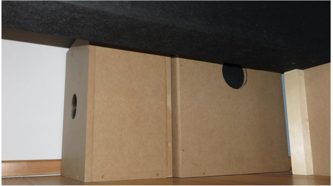
Obr 3.8: Umístění Helmholtzových rezonátorů
