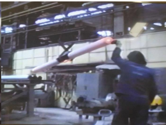
Obr.32: Přemístění trubky jeřábem [17]
