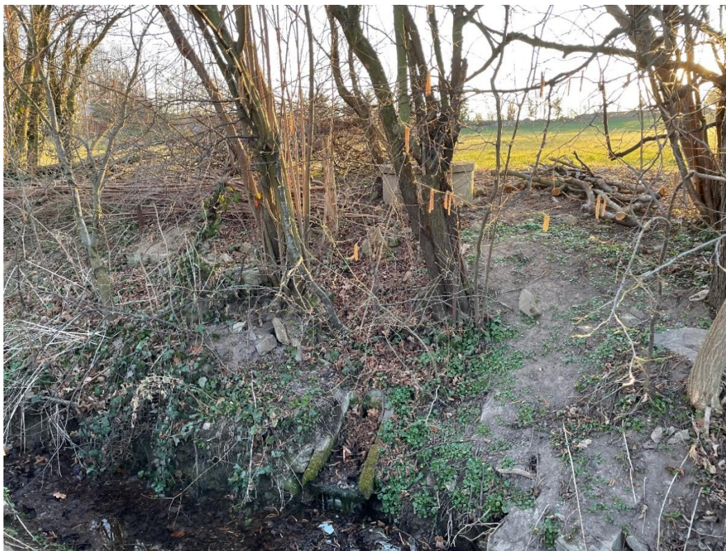
Příloha č. 12 Drenážní šachtice a výúst' odvodňovací stavby M3
