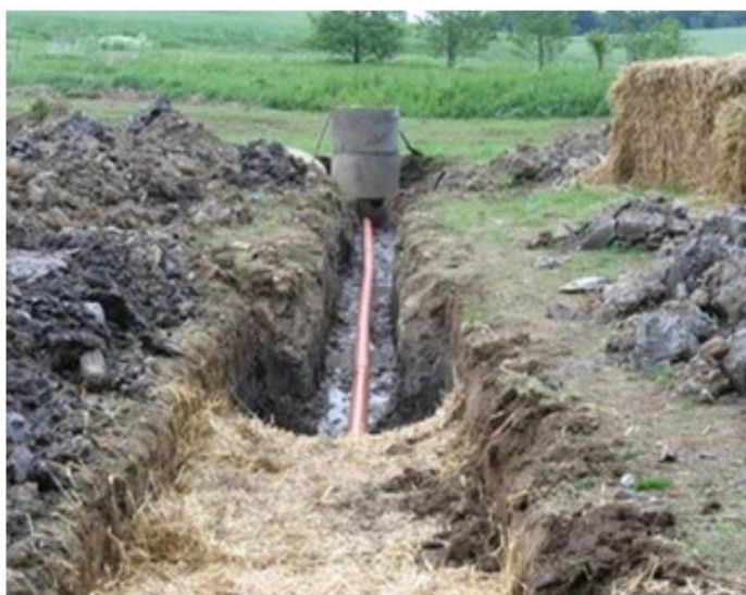
Obrázek č. 27 - Ukázka drenážního biofiltru (foto F. Doležal, VÚMOP)
