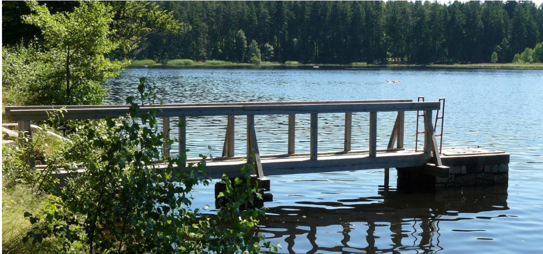
Obr. 16: Ukázka dřevěné lávky a požeráku obloženého lomovým kamenem (Kašpaříková, 2011)
