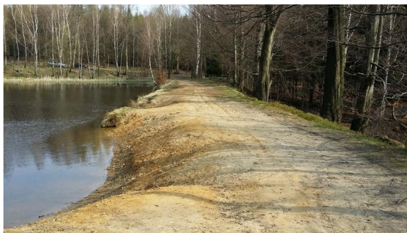
Obr. 6: Pohled na největší zúžení koruny hráze o 3 m (autor)
