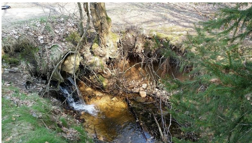
Obr. 10: Pohled na výtok z výustního objektu z koruny hráze (autor)
