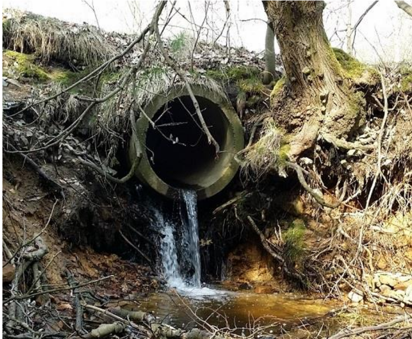
Obr. 11: Pohled na výtok z výustního objektu (autor)
