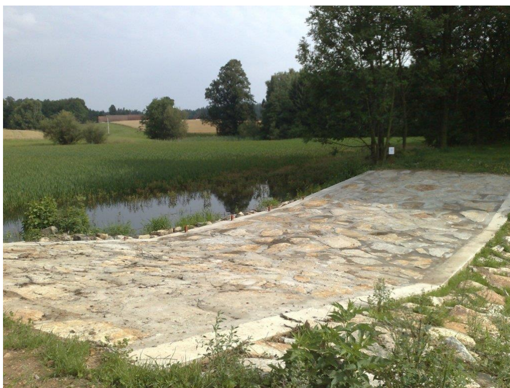
Obr. 19: Ukázka bezp. přelivu z lomového kamene (Studenský občasník, 2011)
