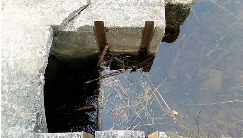
Obr. 9: Pohled na výustní objekt (autor)
