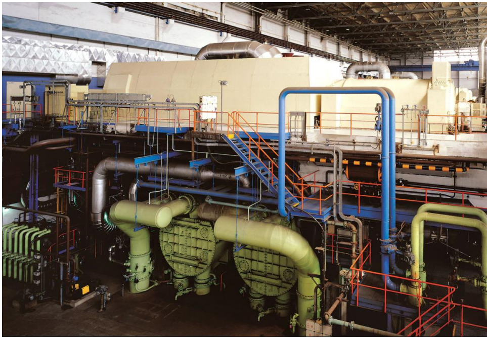
Obr. 4.1 Kondenzátory parní turbíny [20]
