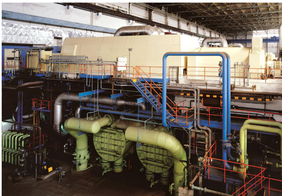
Obr. 4.1 Kondenzátory parní turbíny [20]
