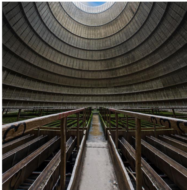
Obr. 4.3 Systém rozvodných kanálů chladicí věže [13]
