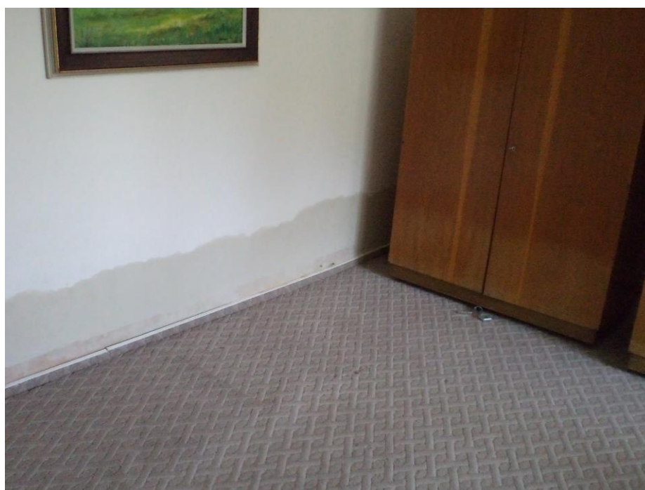
Obrázek 10 - Promočené zdi v jedné z nemovitostí Zdroj: archiv OÚ Čičenice
