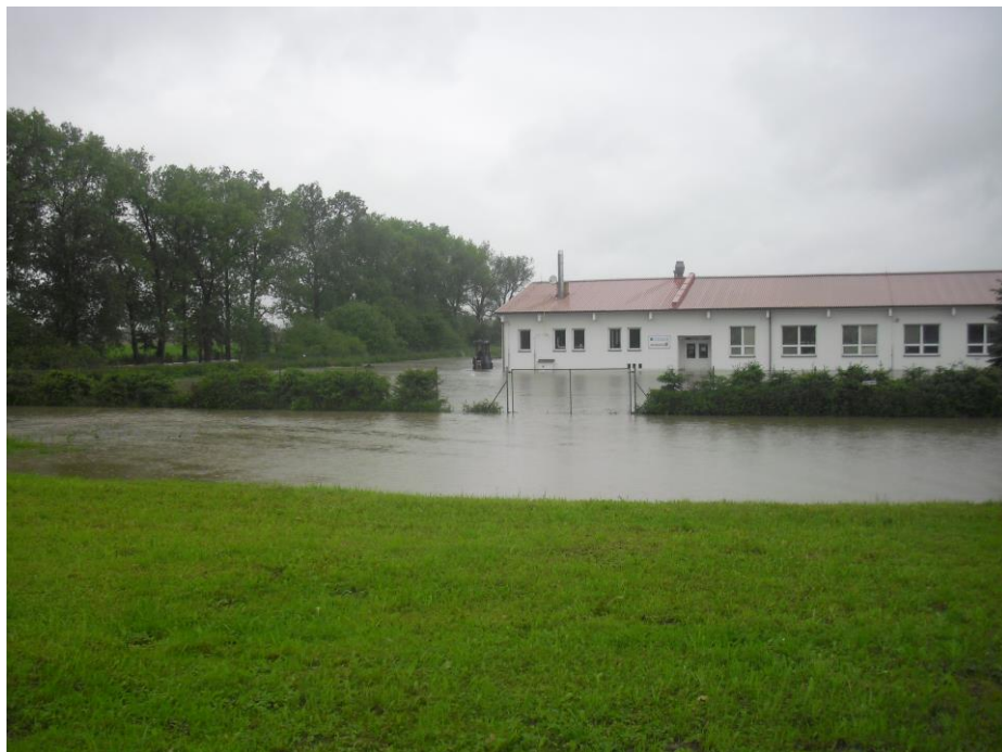
Obrázek 5 - Zaplavený areál firem Deutronic s. r. o. a Sedlbauer s. r. o. Zdroj: archiv OÚ Čičenice
