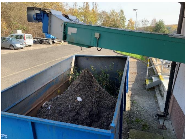
Obr. 37: Kontejner na skladování shrabků a písku (vlastní foto)
