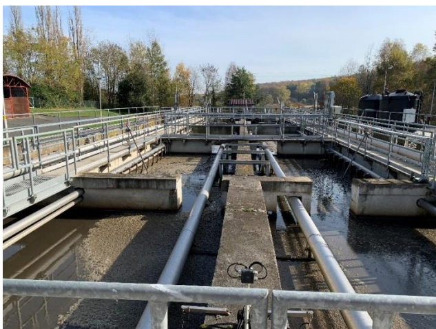
Obr. 34: Denitrifikační a nitrifikační sekce aktivačních linek (vlastní foto)
