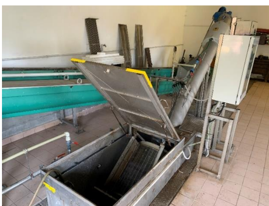
Obr. 32: HUBER - kombinované rotační síto (vlastní foto)
