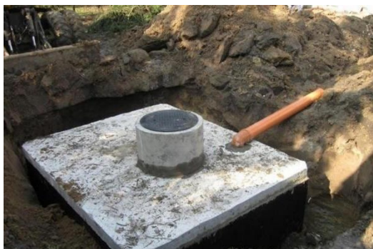
Obr. 18: Železobetonová žumpa s výkopem (dostupné z: https://voda.tzb-info.cz/126336-zelezobetonove-zumpy )
