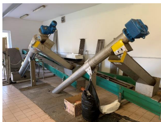
Obr. 33: HUBER - lapače písků a lisy na shrabky (vlastní foto)
