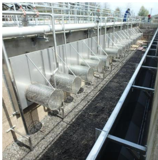
Obr. 41: Pohled na odtokový koridor (PŘ ČOV Tlučná VP, 2022)
