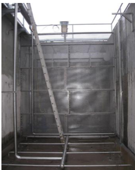
Obr. 38: Pohled na odtokové síto před úpravou (PŘ ČOV Tlučná VP, 2022)
