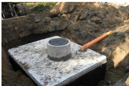
Obr. 18: Železobetonová žumpa s výkopem (dostupné z: https://voda.tzb-info.cz/126336-zelezobetonove-zumpy )
