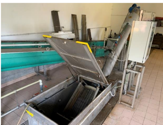
Obr. 32: HUBER - kombinované rotační síto (vlastní foto)
