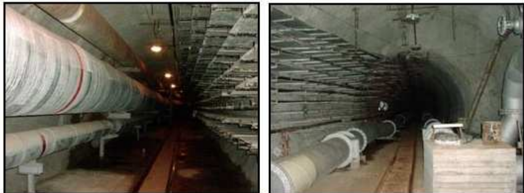
Obr. 2-9 Primární kolektory města Brna [9]
