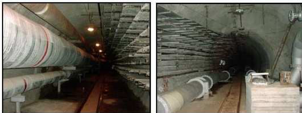
Obr. 2-9 Primární kolektory města Brna [9]
