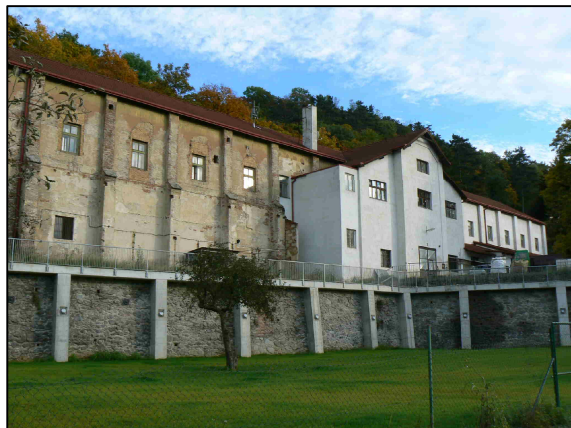
ZÁPADNÍ POHLED-LEVÝ TRAKT 19.10.2014 (JŮZKO, 2015)
