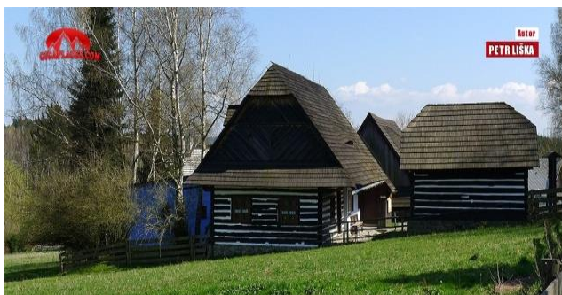
2. obr.: Vstupní usedlost Zdroj: Gigaplaces.com, [34]
