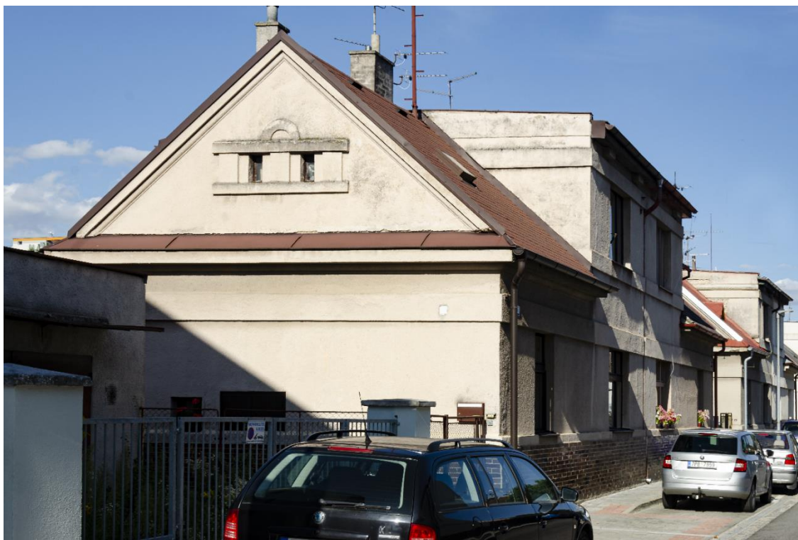
Obr. 26 Dvojďům čp. 214 a 215 (dnešní čp. 103 a 110) v roce 2024. Všimněme si dekorativního prvku ve štítě.
